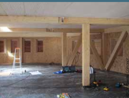
La salle de réfectoire avec plafond acoustique
